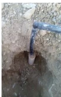
شکل ۱. کارگذاری قطعات در عمق ۳۰ سانتی متری و فاصله ۳۰
